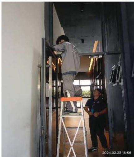
เจ้าหน้าที่ฝ่ายช่างตรวจสอบ และซ่อมแซมประตู/หน้าต่างระบายอากาศ
