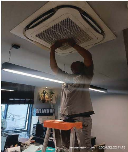
เจ้าหน้าที่ทำความสะอาดแผ่นกรองอากาศ
