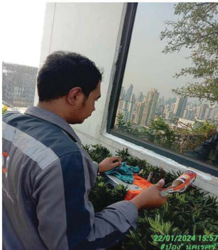
เจ้าหน้าที่ฝ่ายช่างตรวจสอบ และอุดรอบรั้วผนัง ฝ้าเพดาน
