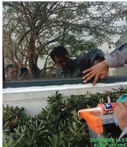
เจ้าหน้าที่ฝ่ายช่างตรวจสอบ และอุดรอบรั้วผนัง ฝ้าเพดาน
