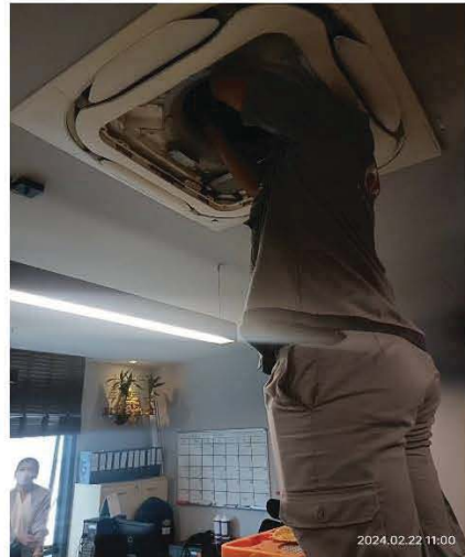
เจ้าหน้าที่ทำความสะอาดแผ่นกรองอากาศ
